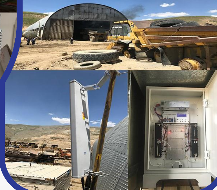
پروژه تهیه و نصب تجهیزات تقویت logar bts [ آنتن موبایل ] معدن زرشوران (آذربایجان غربی)
